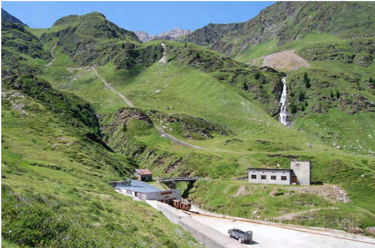
Abb. 8: Das Mundloch des Poschhausstollens mit angebautem Schneekragen ( links )
