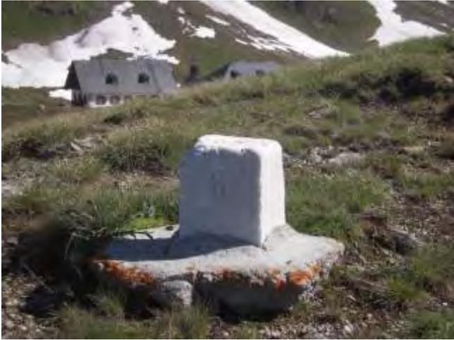
Abb. 3: Beispielfoto des Marmorpunktes *MP 6*. Mit derartigen Punkten wurde das trigonometrische Vermessungsnetz in der zweiten Blütephase des Abbaus vermark. Im Hintergrund ist die Schutzhütte am Schneeberg (damals Herren- und Gasthaus) zu sehen (Wandinger M, 2010).
