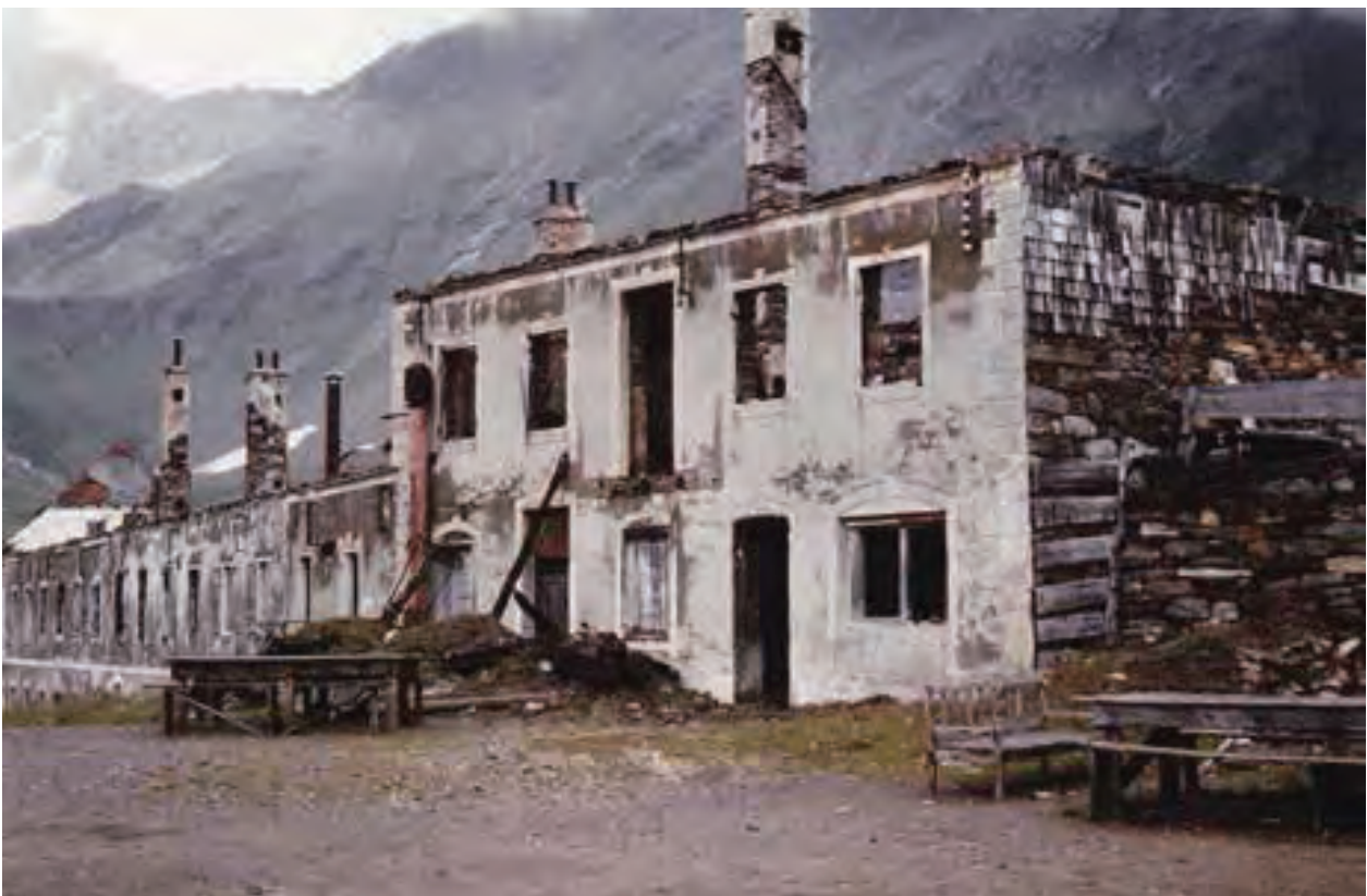
Abbildung 14: Ruine der Knappenkaue. Im rechten Gebäudeteil befand sich im Erdgeschoss eines der beiden Mundlöcher des Martin-Stollens, um auch im Winter leichten Zugang der Arbeiter in die Grube sicherzustellen (das Mundloch ist heute noch erhalten). In diesem Gebäude befand sich auch der Kompressor, dessen Luftansaugstutzen etwas links der Bildmitte zu sehen ist. Auf dieses Kompressorengebäude bezieht sich auch eines der drei Spannmaße in der Einmessungsskizze des Nullpunkts (Abb. 11), doch leider ist vor ca. 20 Jahren das Gebäude abgebrochen worden. Foto: Marcus Wandinger, August 1982
