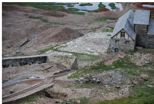
Seemoos Talstation mit Turbinenhaus
