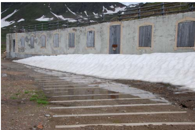
Alter Bahnhof in St. Martin
