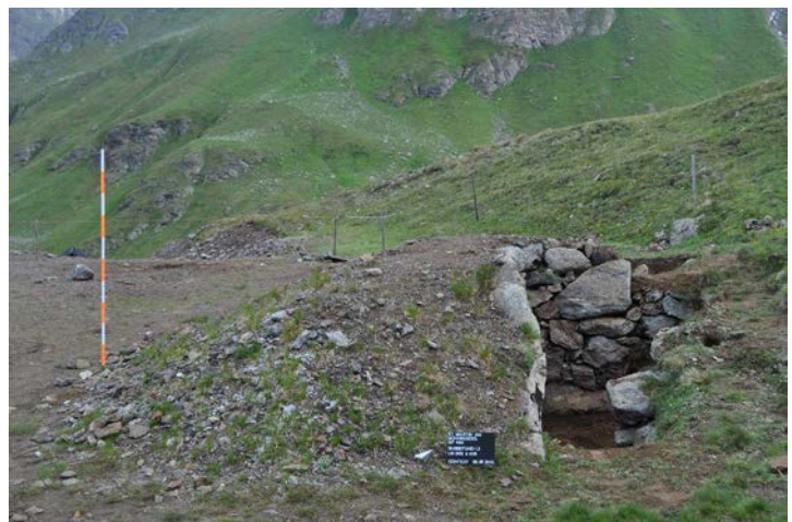
Abb. 10: Blick in den Fundamentbereich des Pochwerks am St.Christoffi-Stollen (CONTEXT OG).
