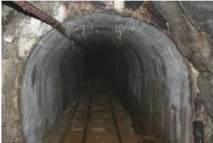
Die kritischen Ausbauten, wo bereits Risse ersichtlich waren, wurden mit Stahlbögen im Abstand von ca. 1m verstärkt. Aus optischen Gründen wurden in die Zwischenräume der Stahlträger abschnittsweise Bohlen bzw. Rundhölzern eingebaut.
