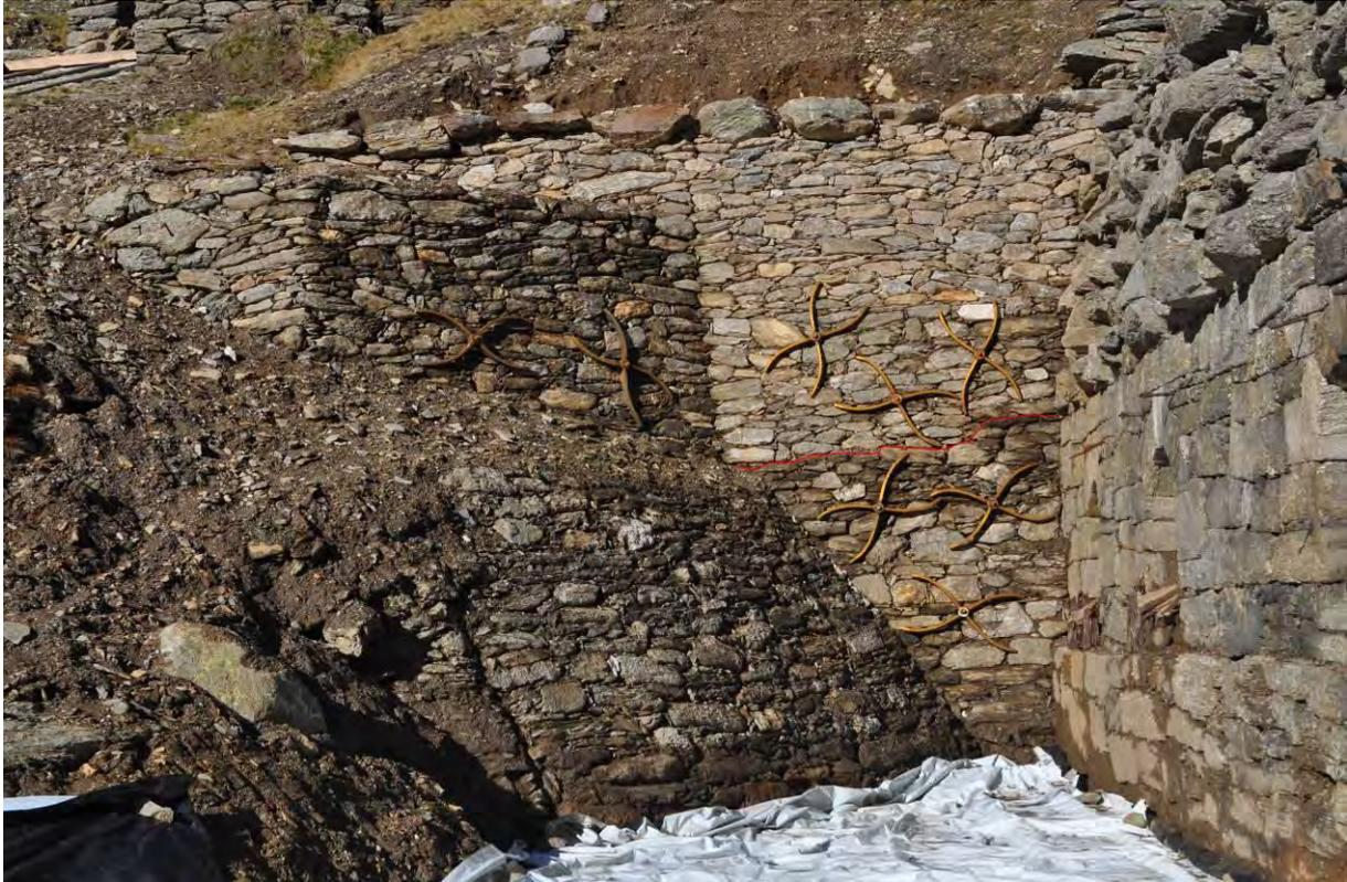
Abbildung 1: Sanierter Mauerbereich am "Unteren Lazzacher Erzkasten". Sanierungsmaßnahmen: Neue Maueranker, Neuaufbau des Mauerbereichs oberhalb der roten Linie (hellerer Mauerbereich im rechten zentralen Bildbereich)
