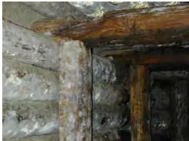
Die konstruktiv tragenden Zimmerungen werden mehrmals jährlich auf ihren Zustand geprüft. Von Pilzen angegriffene und geschwächte Hölzer werden erneuert.
