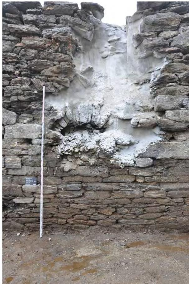
Abbildung 5: „Unterer Lazzacher Erzkasten“: Dokumentation der prophylaktischen Sicherungsmaßnahmen (Spritzbeton) im Vorfeld der Restaurierungsmaßnahmen (Arbeitsstand: Herbst 2010).
